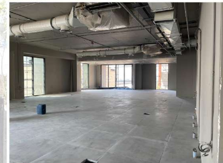
نمایش تاسیسات مکانیکی به صورت اکسپوز
