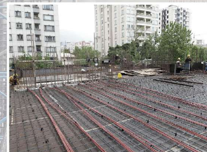
اجرای سقف پیش تنیده پس کشیده
